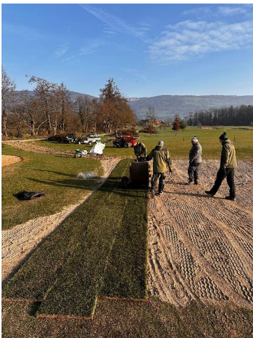
Verlegen der 60cm-breiten Soden auf Vorgreen 1 und 2 Rot
