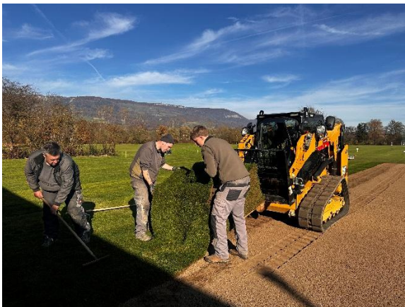
4. Schritt: Verlegen der Rasensoden
