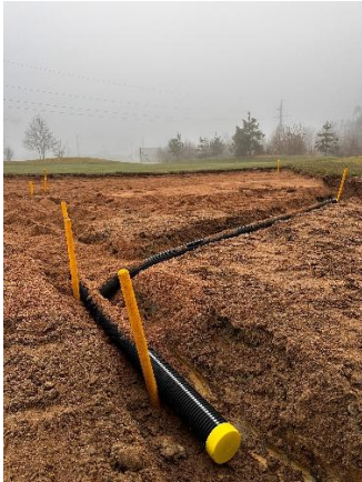
Bei Vorgrün 1 Rot sind die neuen Dränrohre...
