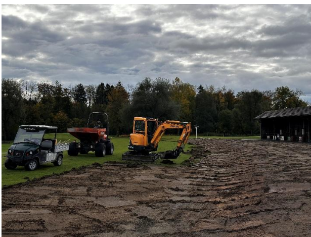
1. Schritt: Absoden
