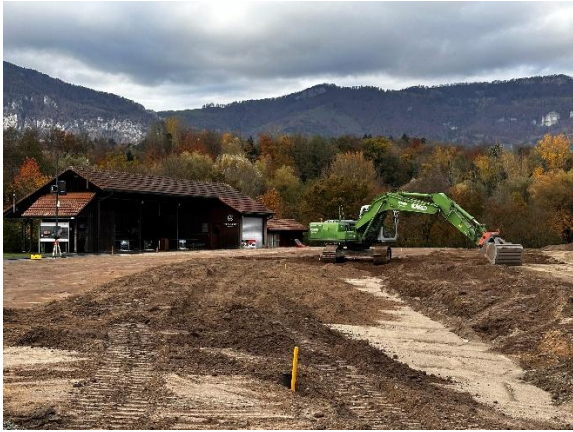
3. Schritt: Alles auf gleiches Niveau bringen
