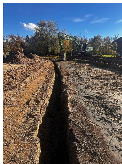
2. Schritt: Einbau zusätzliche Drainage
