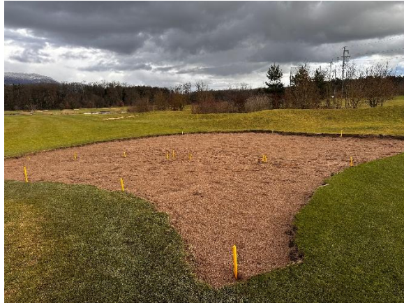
...und eine durchlässige Dränschicht bereits eingebaut
