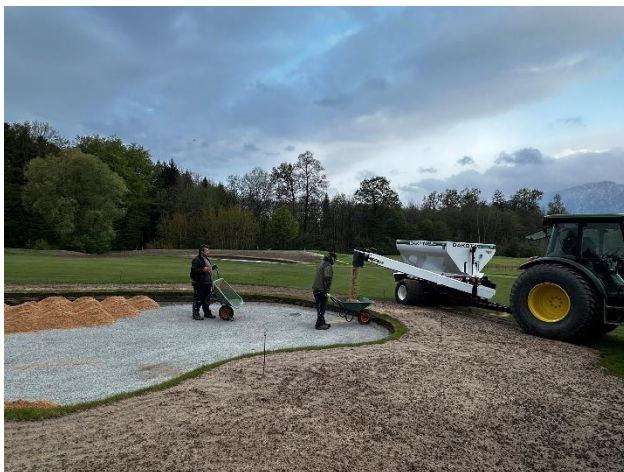
Verfüllen der Bunker mit Sand
