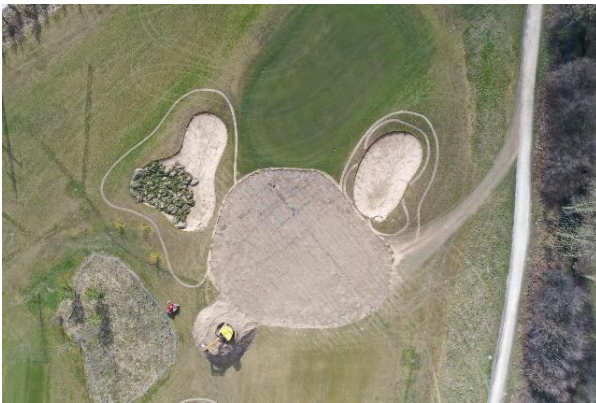
Neubau Vorgreen 1 und Bunkersanierung
