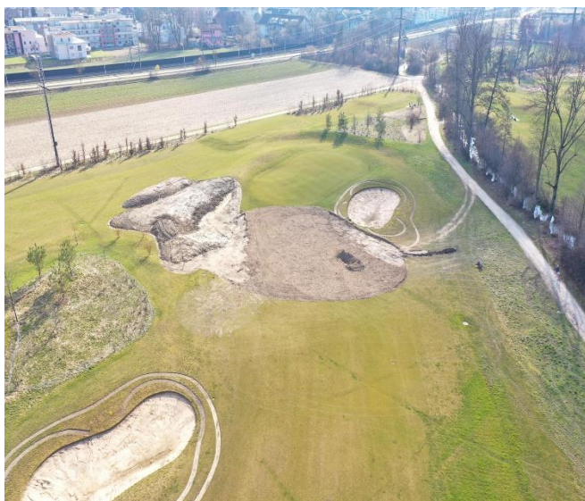
Vorgreensanierung auf der Spielbahn 1
