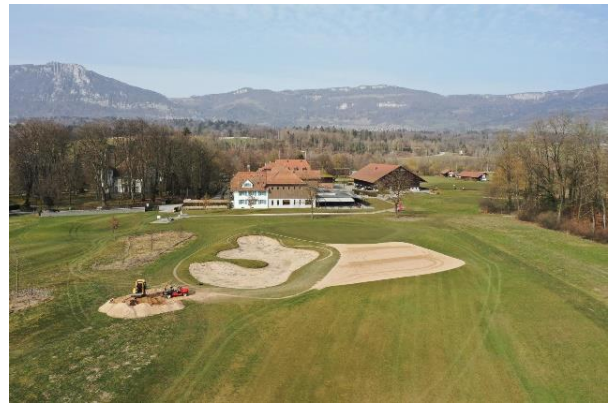
Neubau Vorgreen 9 mit Bunkersanierung
