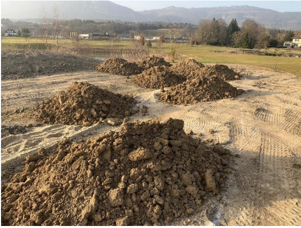
Renaturierung Bunker Bahn 2
